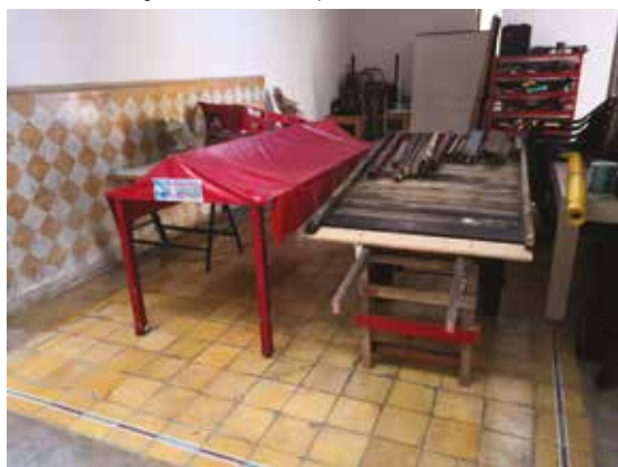
Fig. 17. Inicio de las reparaciones. Se conservaron algunos elementos como el letrero del techo.
